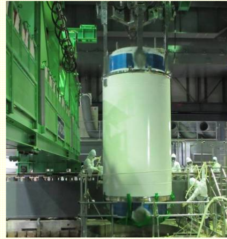
<最後の燃料輸送容器の搬出作業状況>
