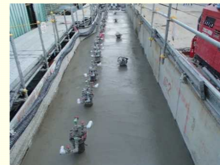
<陸側遮水壁海側 凍結管設置状況>
