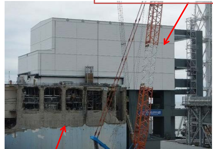
燃料取り出し用カバー
