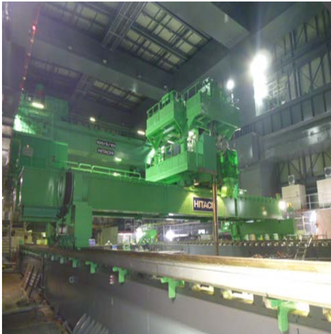
【4号機の燃料取り出し用カバー内部】
