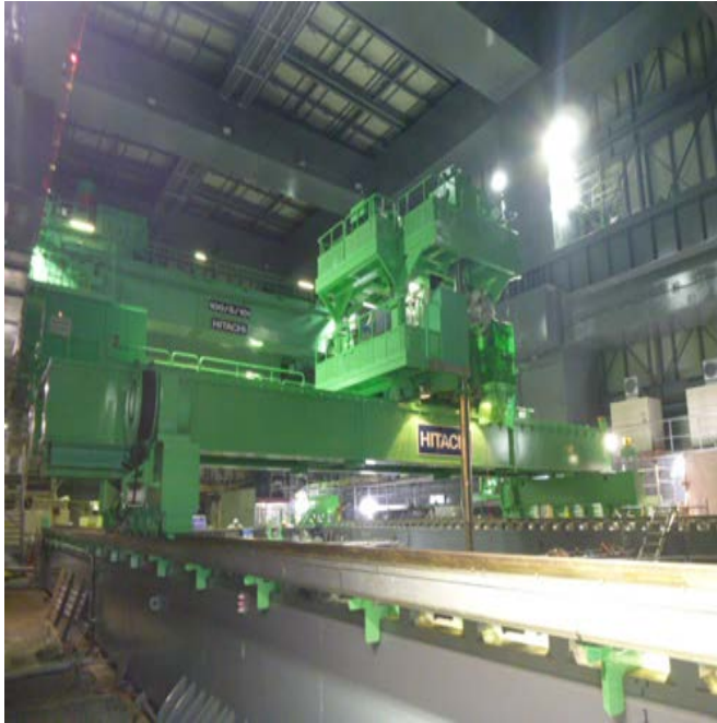
【4号機の燃料取り出し用カバー内部】
