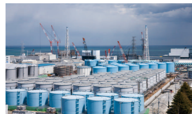
計画的にタンク約900基を設置 (1基あたり約1000~3000トンを貯蔵)
