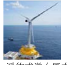
浮体式洋上風力発電設備
