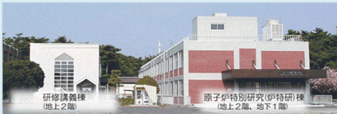
図1：研修講義棟と原子炉特別研究棟
