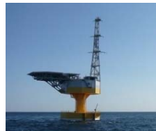
洋上変電所 「ふくしま絆」
