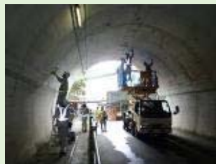
(トンネル点検)
