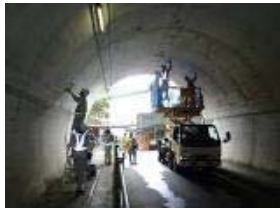
(トンネル点検)
