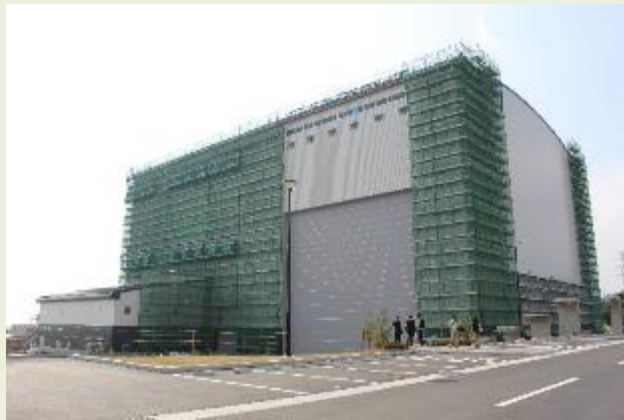
試験棟(建設中)
