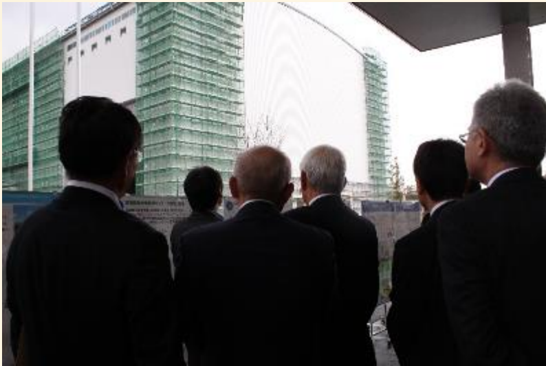
試験棟工事状況(遠景)視察
