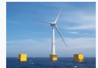
設置完了した7MW風車「ふくしま新風」 (福島洋上風力コンソーシアムHP)
