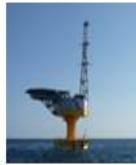
洋上変電所 「ふくしま絆」
