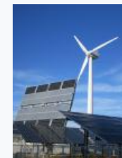
産総研福島再生可能エネルギー研究所の風車と追尾式太陽光パネル
