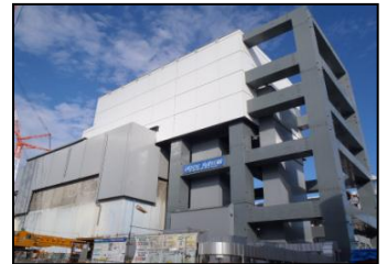
燃料取り出し用カバー完成
