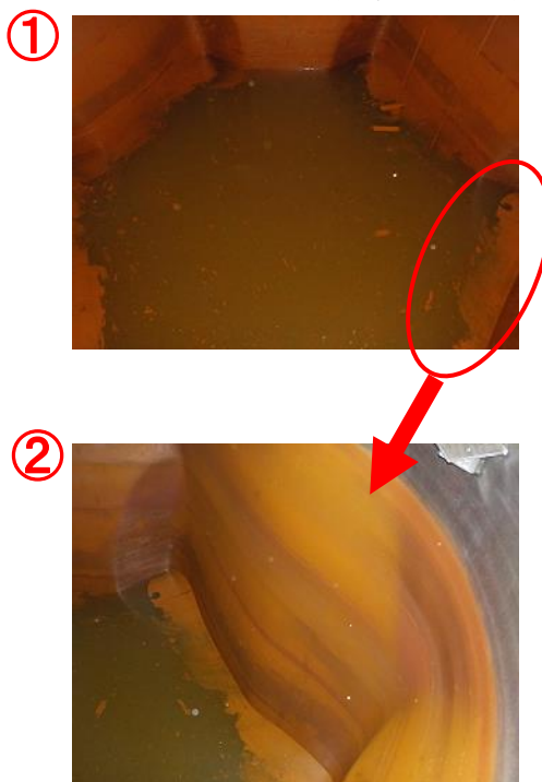
タンク内面状況(6月22日)
