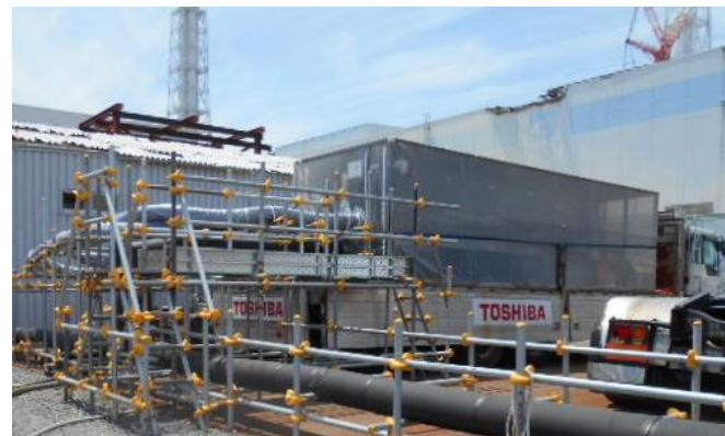
モバイル式処理装置
