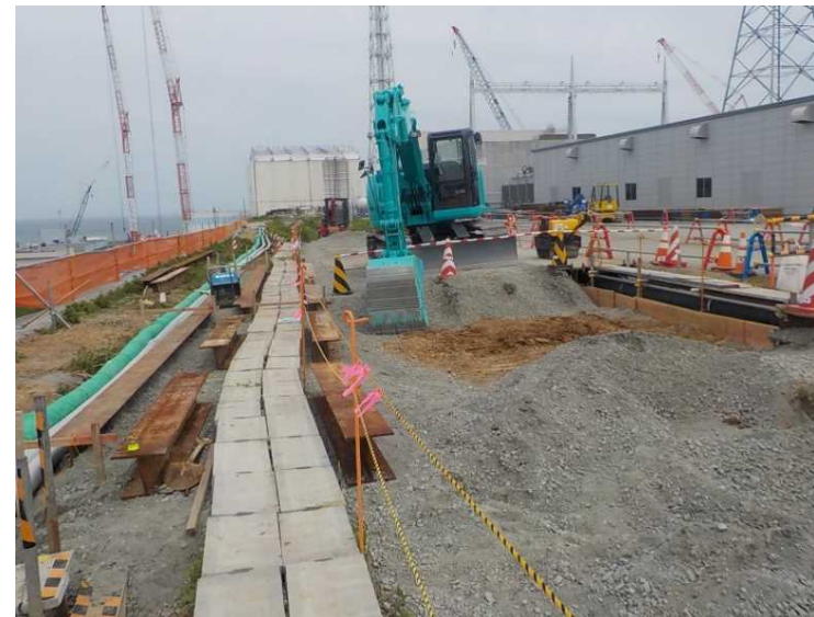
写真④ 地下水BP工リア接続柵 既設設備防護
