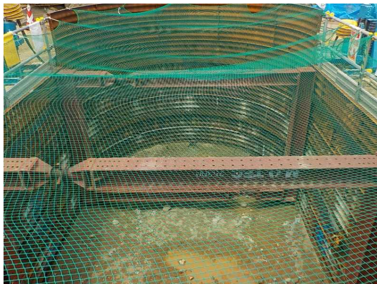
写真② 接続柵部 立坑構築
