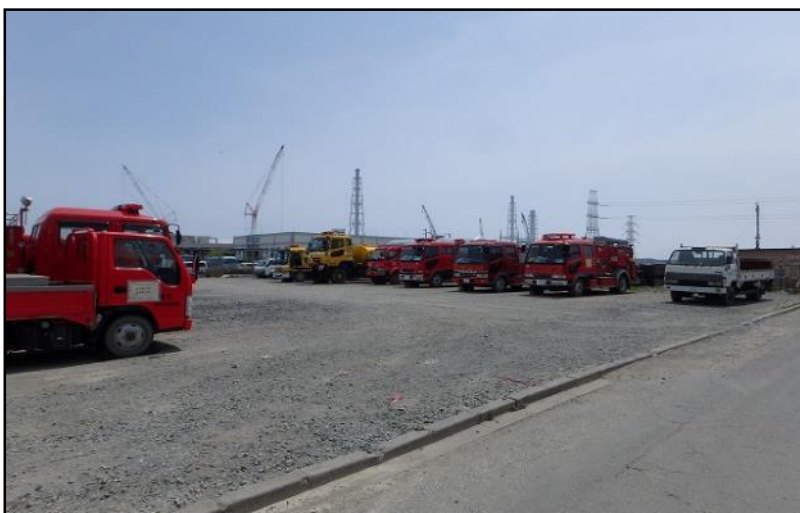
【写真②(35m盤)】北側エリア:舗装施工前
