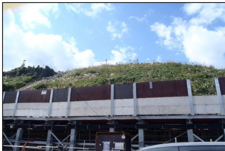
【写真③(35m盤)】1～4号法面:表土剥ぎ取り施工前
