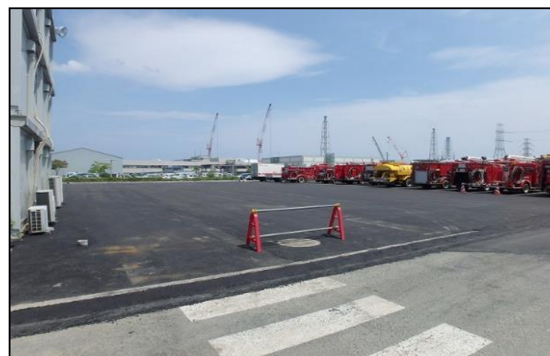
【写真②(35m盤)】北側エリア:舗装施工後
