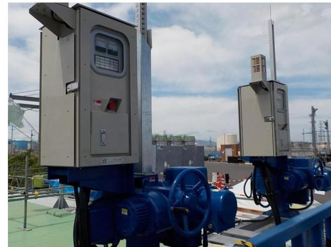
写真 自動・遠隔制御盤設置状況
