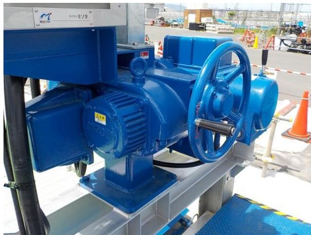
写真 ゲート巻上機電動化状況
