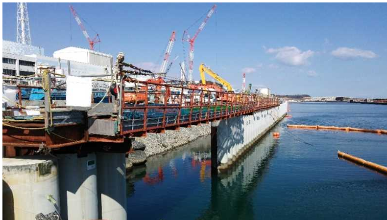
＜鋼管矢板打設前＞
