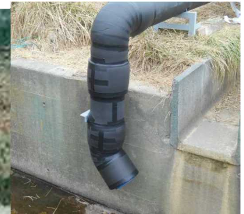
旧C排水路 の排水口
