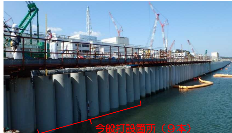
＜鋼管矢板打設完了後＞
