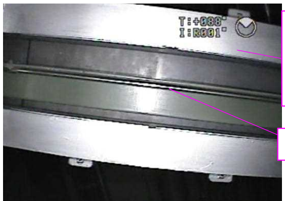
写真③：案内管鉛遮へい部（下から見上げる）
