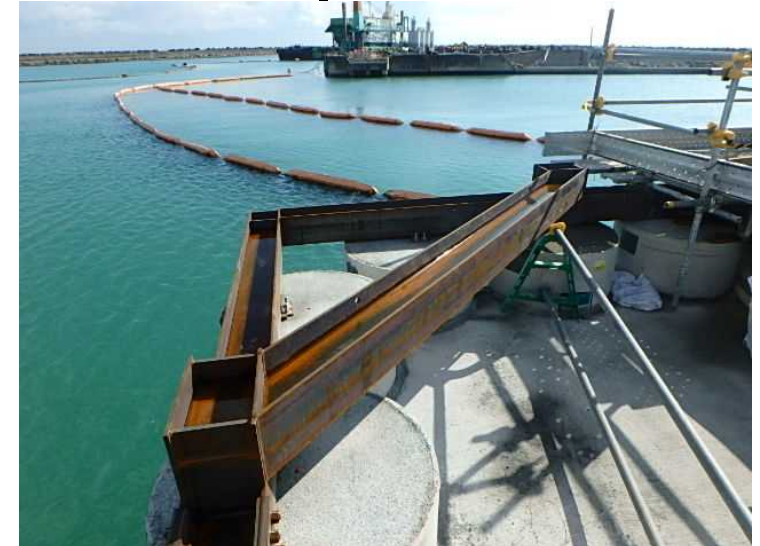
コーナー部における鋼材の補強状況
