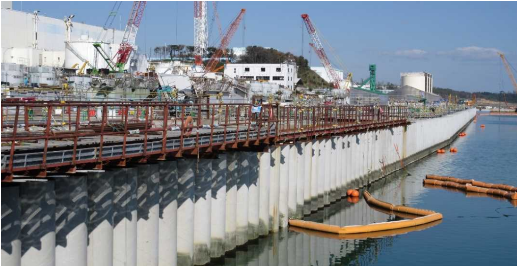
＜閉合作業完了後＞
