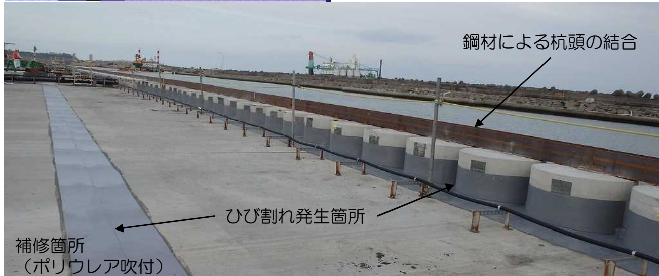
補修実施状況（ポリウレア吹付箇所の一例）
