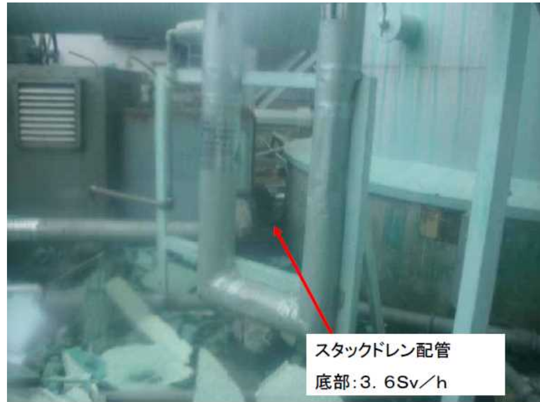
撮影場所：1・2号機主排気筒 スタックドレン配管（西側から撮影） 撮影日時：平成23年8月4日 15時30分頃 撮 影：東京電力株式会社
