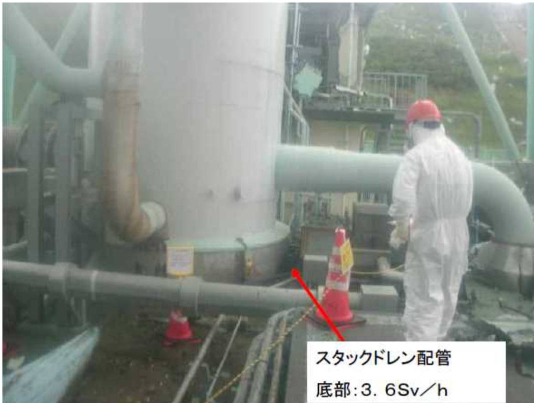
撮影場所：1・2号機主排気筒 スタックドレン配管（東側から撮影） 撮影日時：平成23年8月4日 15時30分頃 撮 影：東京電力株式会社
