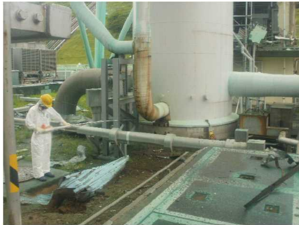
撮影場所：1・2号機主排気筒底部 非常用ガス処理系配管接合部付近 撮影日時：平成23年8月1日 14時30分頃 撮影者：東京電力株式会社
