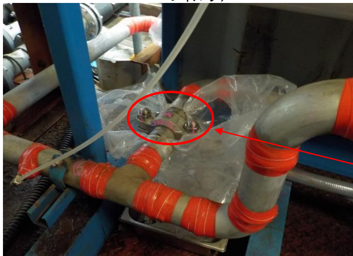
ブースターポンプ出口配管継手部
