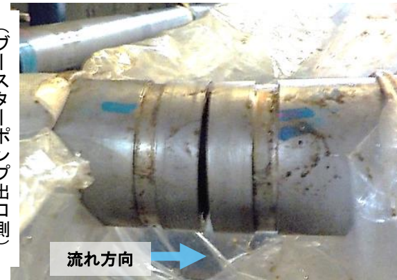
③ 継手取付部配管 目視点検状況 (ハウジング及びゴムリングとの 接触部に、傷、腐食等の異常なし)
