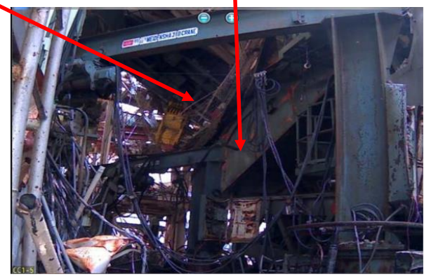
⑨ オペフロ南側ハッチ上部
