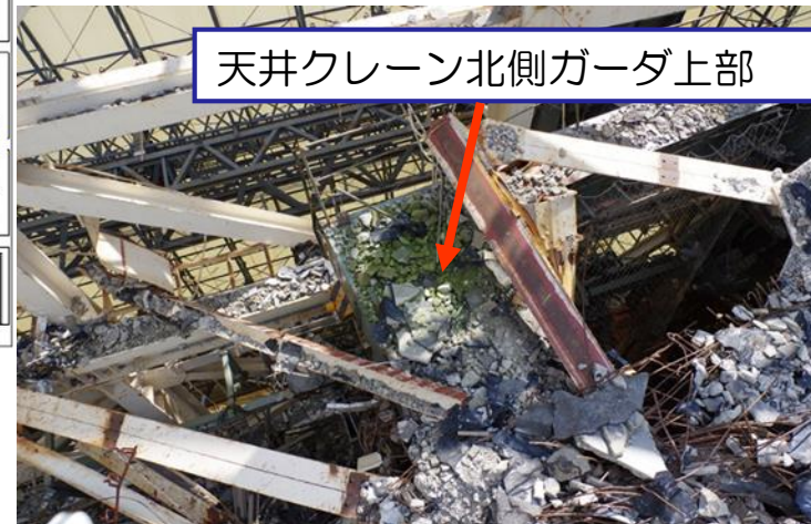
④ オペフロ南東部ガレキ状況 （北西方向から撮影）
