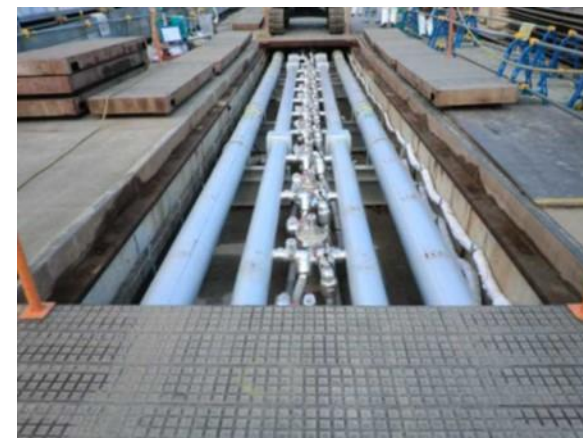
2016.1 グライヴ配管施工完了
