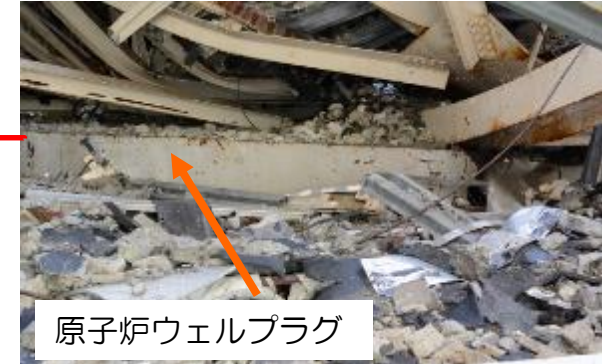
写真3 原子炉ウェル上ガレキ (東面から撮影)
