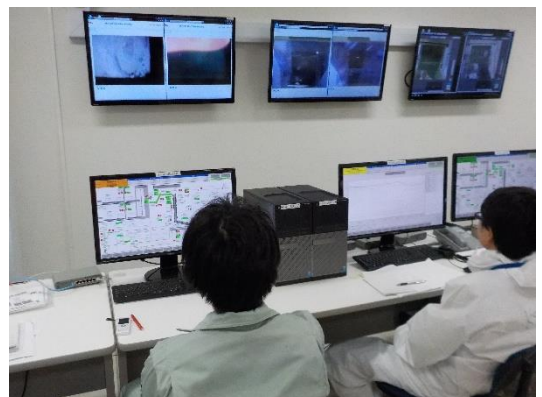
制御室 試験作業状況
