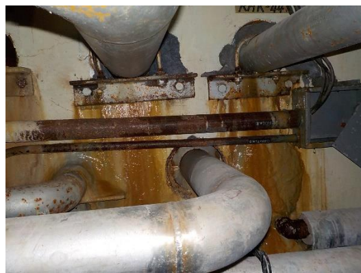
写真② 3号機廃液サージ配管ダクト 貫通部 【止水処置前】
