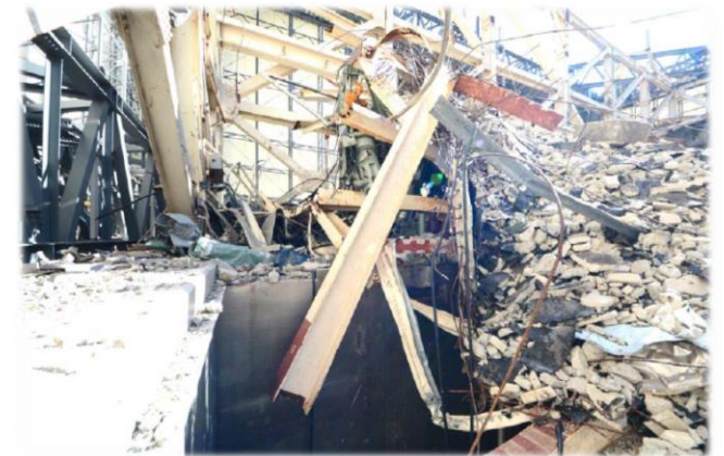
⑪DSP開口部付近状況
