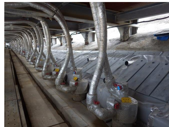
2015.4～2015.12 地表面断熱工
