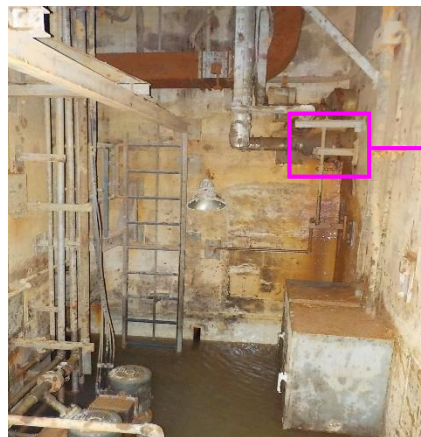
写真① 床ドレンサンブエリア 配管貫通部 【止水処置前】
