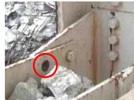
梁接合部ボルトなし
