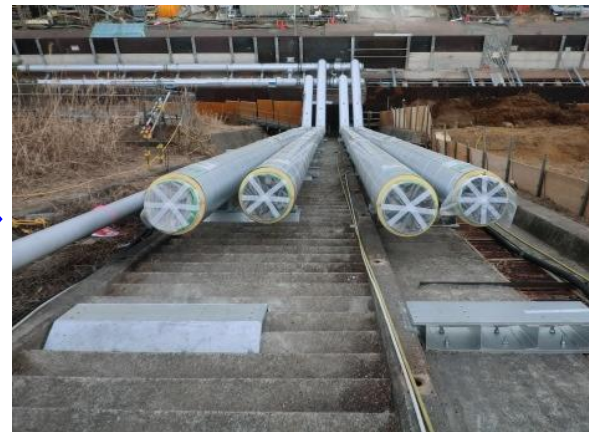
2014.9 グライヴ配管施工開始
