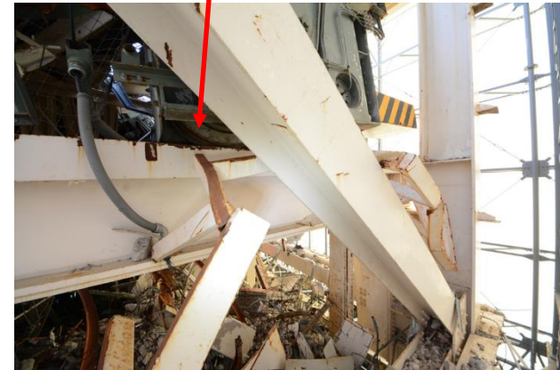
⑱天井クレーン南側ガード端部
