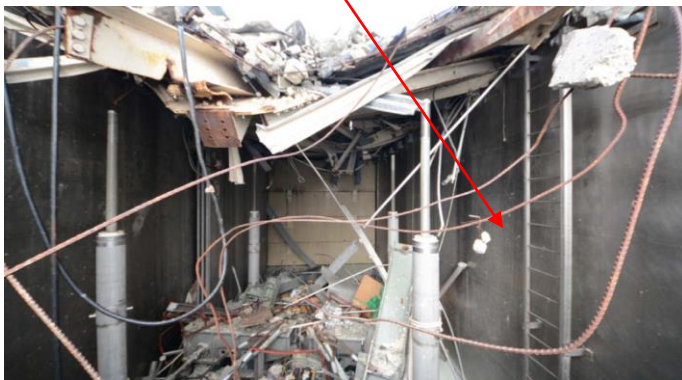
⑩DSP内部のガレキ
