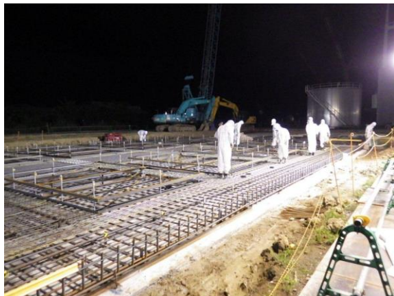
2014.7 プラント基礎配筋
