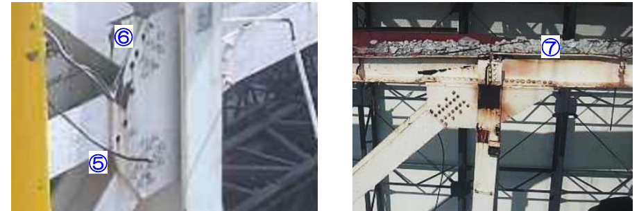
⑤梁接合部、⑥ブレース接合部 ボルトなし
