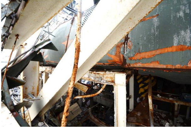
①天井クレーンガーダ(南側)
