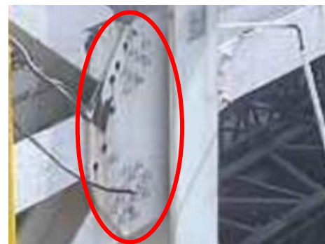
梁・ブレース接合部ボルトなし
