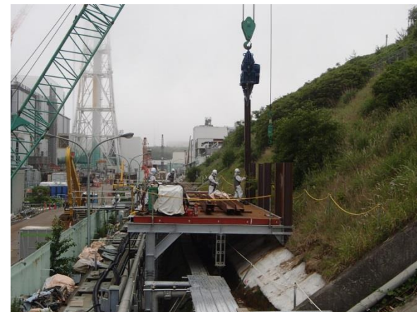
2014.5～2015.7 削孔架台設置
