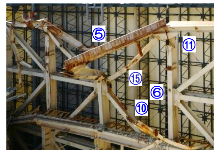
⑤ 梁、柱外れ、⑩ ブレース変形、 ⑪ 柱フランジ外れ ⑮ ブレースフランジ外れ
