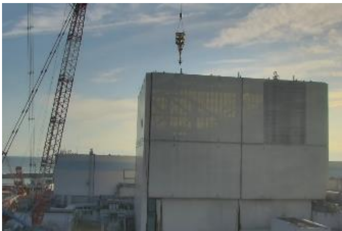
撤去装置吊り込み状況
