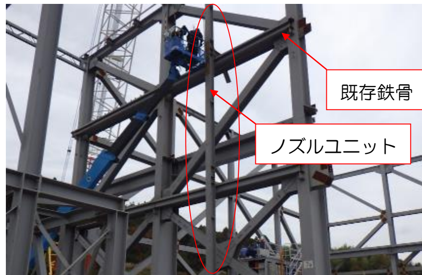
ノズルユニット取付訓練写真（構外ヤード）
