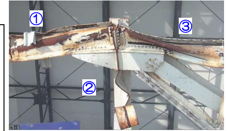
①、③ 梁変形、② 柱フランジ外れ
