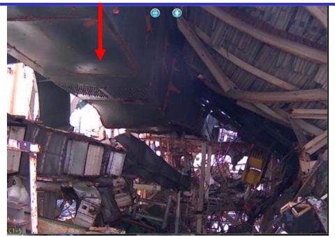
⑬ 天井クレーン南側ガーダ部
