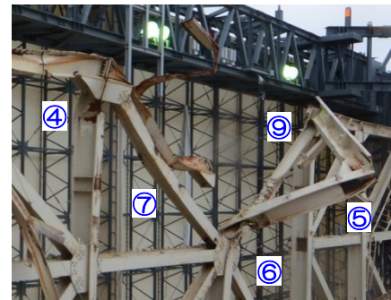
④ 柱フランジ外れ ⑤ 梁、柱外れ、 ⑥ 梁外れ、⑦ ブレース変形、 ⑨ ブレース変形、 ⑮ ブレースフランジ変形
