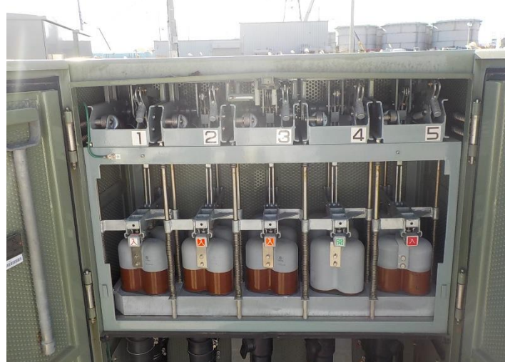
【配電塔No.1 化粧板取り外した状態】
