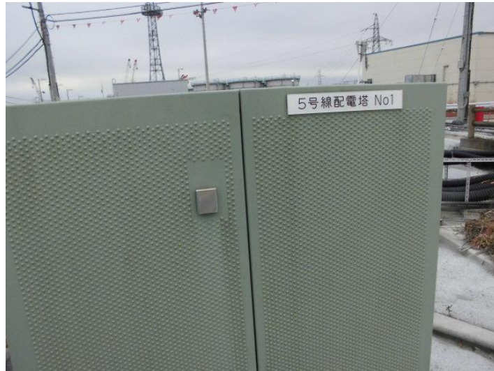
【配電塔No.1 外観】
