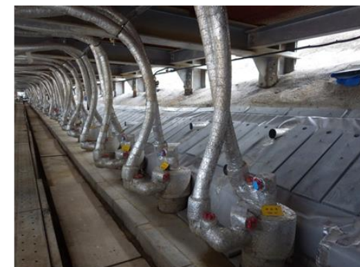
2015.4~2015.12 地表面断熱工
