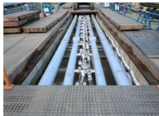
2016.1 ブライン配管施工完了
