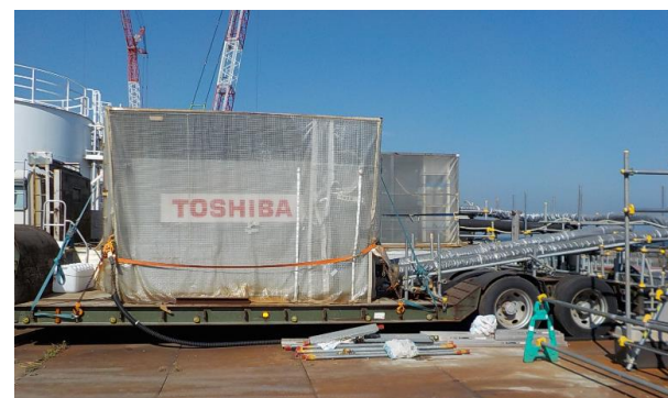
1号放水路浄化装置
