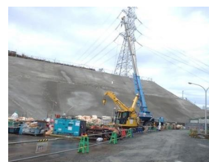
【写真④(35m盤)】1~4号法面:モルタル吹付施工後
