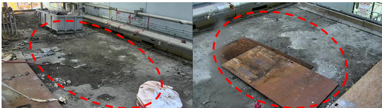
原子炉建屋下屋（東側）でのガレキ吸引作業後
