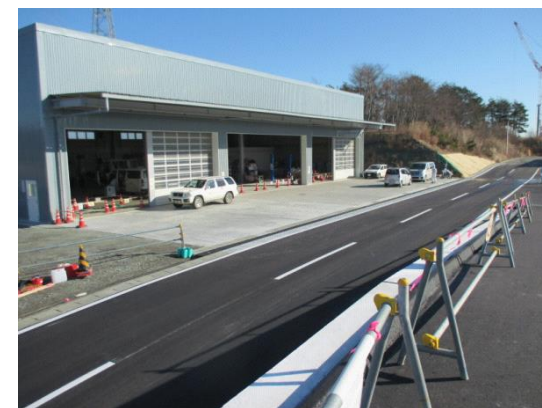
大型車両が進入できる 道路を作った
