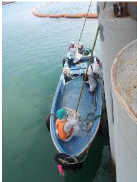
海側遮水壁の外観目視点検状況
