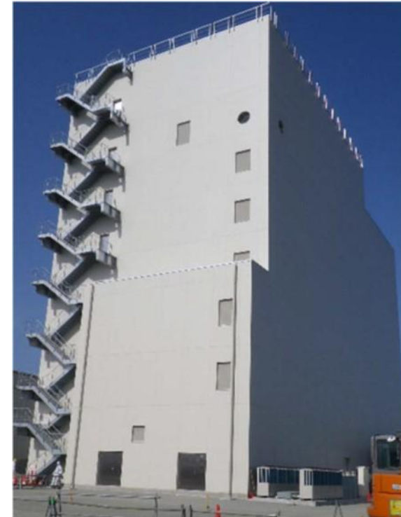
大型休憩所(外観)
