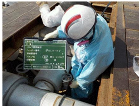
【ヘッダー管バルブ開閉確認状況】
