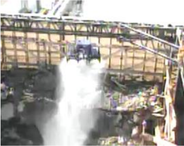
飛散防止剤散布の作業状況写真
