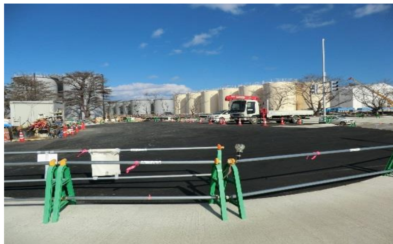
【写真⑥(35m盤)】西側エリア:ふれあい交差点付近アスファルト施工後
