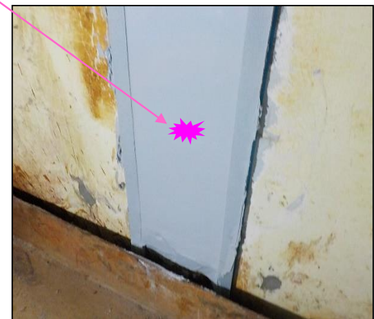
止水処置完了写真
