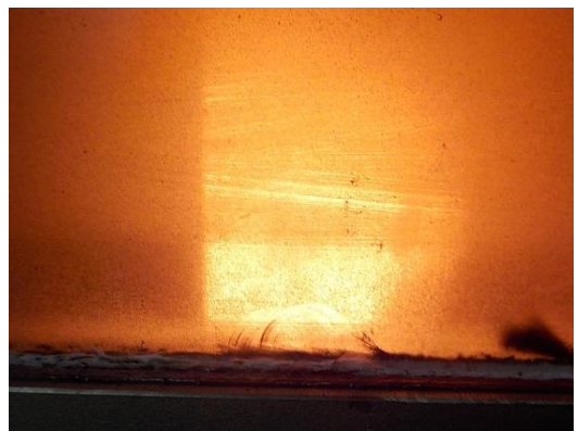
焼却炉内部 (A系) ホット試験 廃棄物燃焼状況
