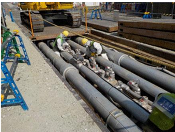
【凍結管バルブ開閉確認状況】
