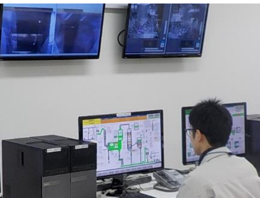
制御室 試験作業状況
