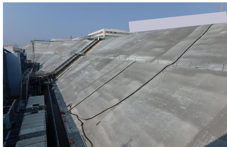
【写真②(35m盤)】北側エリア:旧事務本館法面モルタル吹付施工後
