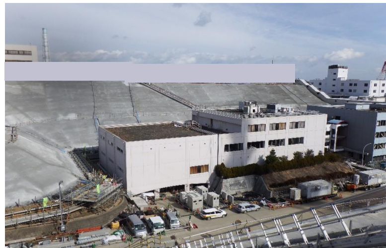
【写真②(35m盤)】北側エリア:旧事務本館法面モルタル吹付施工後
