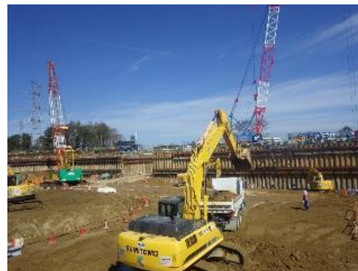
掘削作業 写真②
