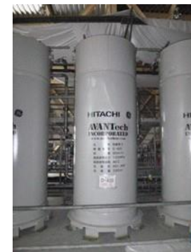
サブドレン等浄化 (吸着塔)
