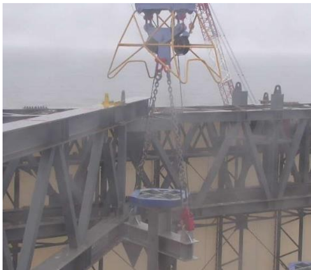
吊り上げ状況（東面）
