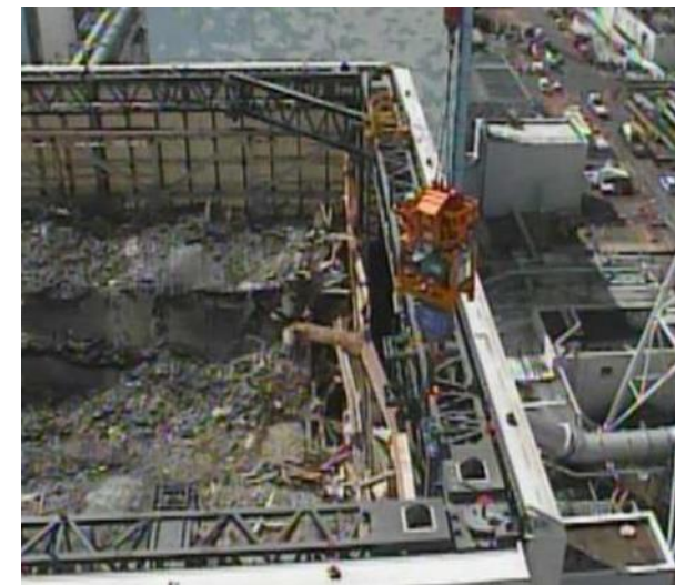
吊り上げ状況（西面）
