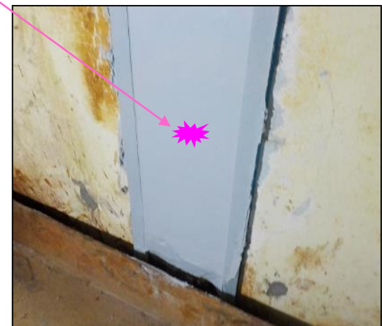
止水処置完了写真
