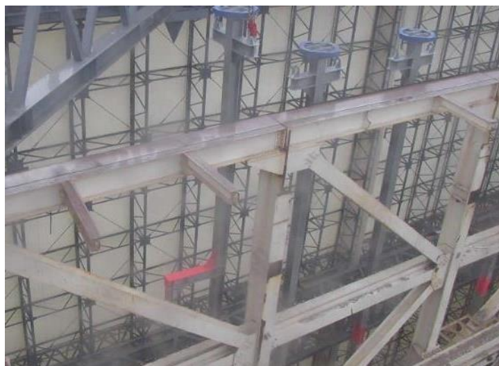
設置状況（東面）
