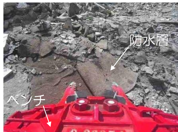
②防水層剥がし
