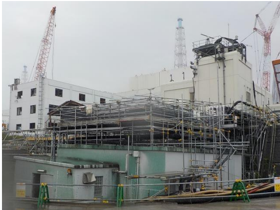
サブドレン移送ポンプ建屋周辺
