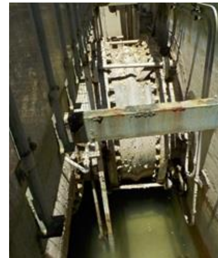
【6月27日移送終了後の配管貫通部（海側）】
