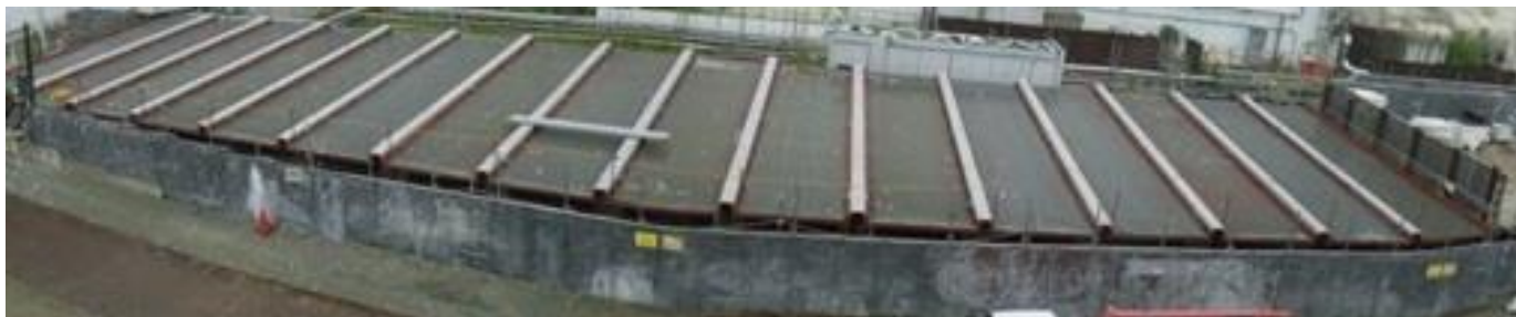
【逆洗弁ピット上部の屋根設置状況】
