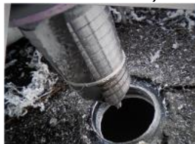
ピット内点検口削孔状況 (9/6実施)
