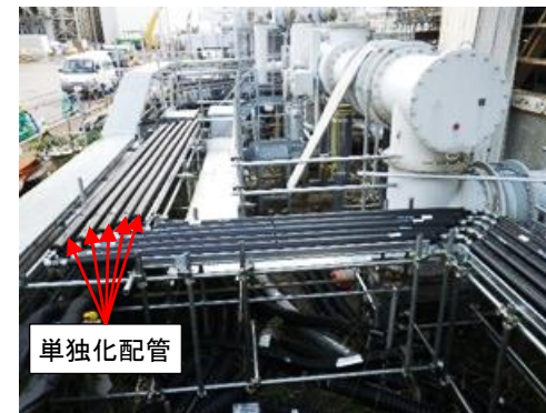
【中継タンクNo.4 北側】
