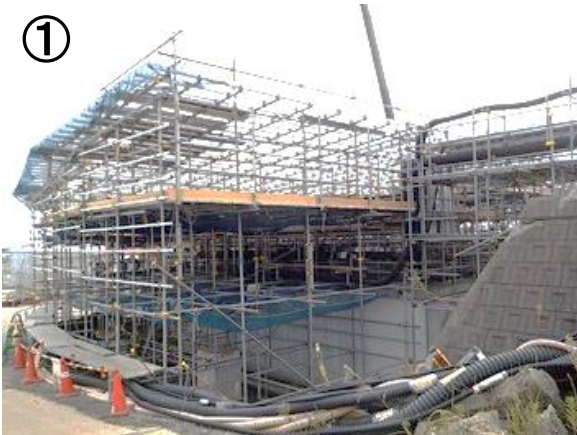
サブドレン移送ポンプ建屋周辺
