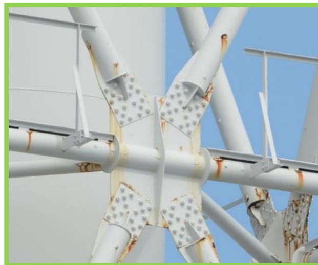
健全と判断した箇所の例（2016年9月）
