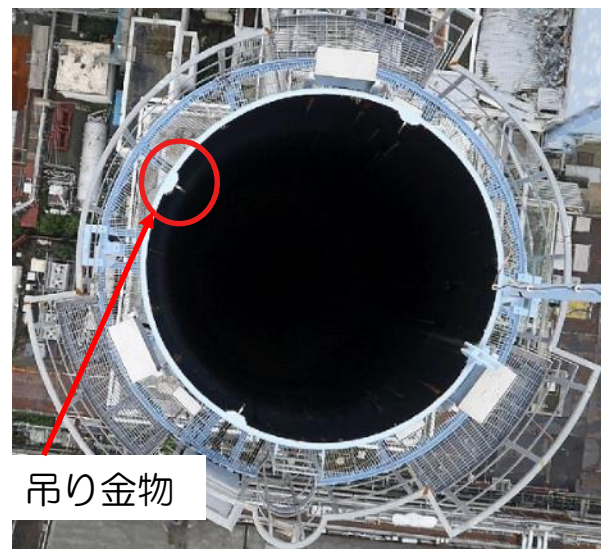
排気筒頂部状況
