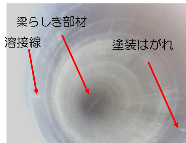
筒身内部状況
