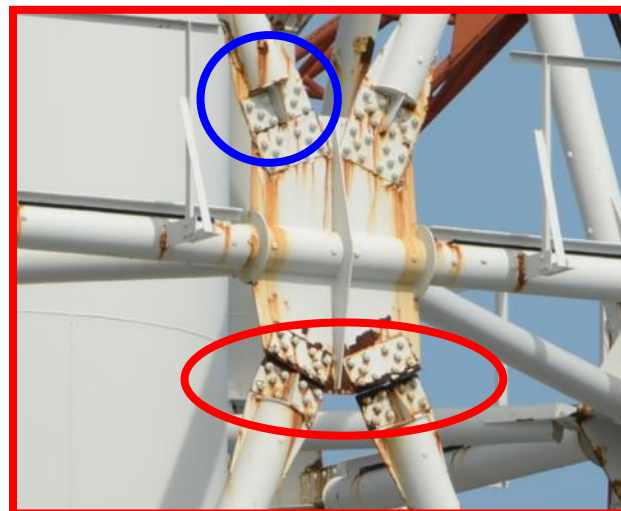
破断及び変形と判断した箇所の例（2016年9月）
