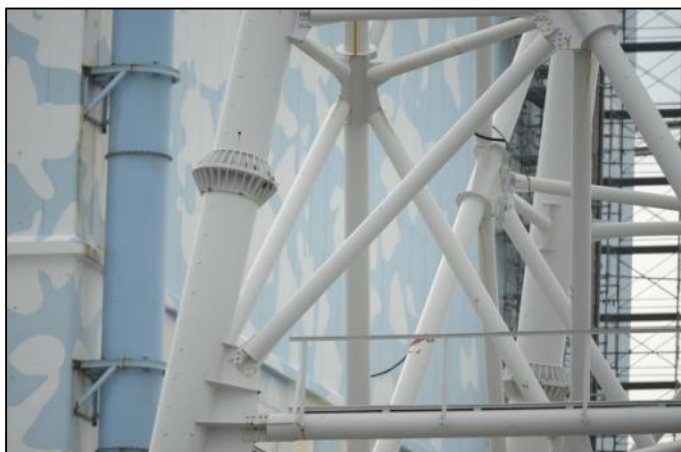
③ 北側（GL19～30m付近） 主柱・斜材
