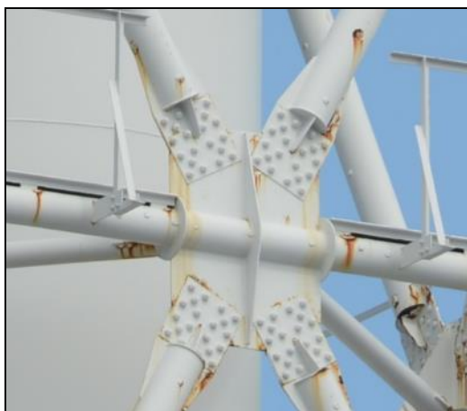
① 南側（GL100m付近） 接合部
