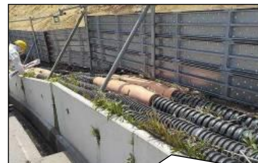
周囲に可燃物がある例 (草むらに布設されている)
