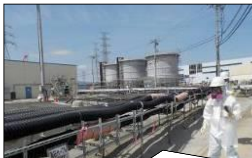
外気温影響がある例 (エフレックス収納かつ屋外布設)
