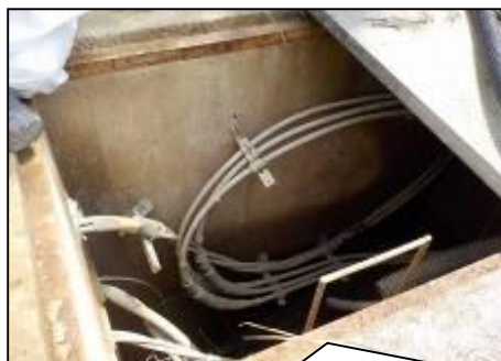
外的応力を受けている例 (湾曲設置されている)
