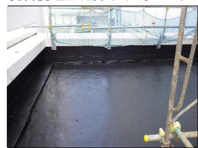
【写真④】仕上げ防水中 (4月25日)
