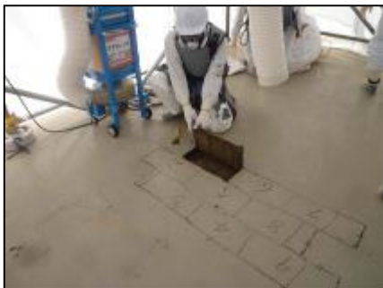
【写真⑤】汚染源撤去開始 (3月30日)
