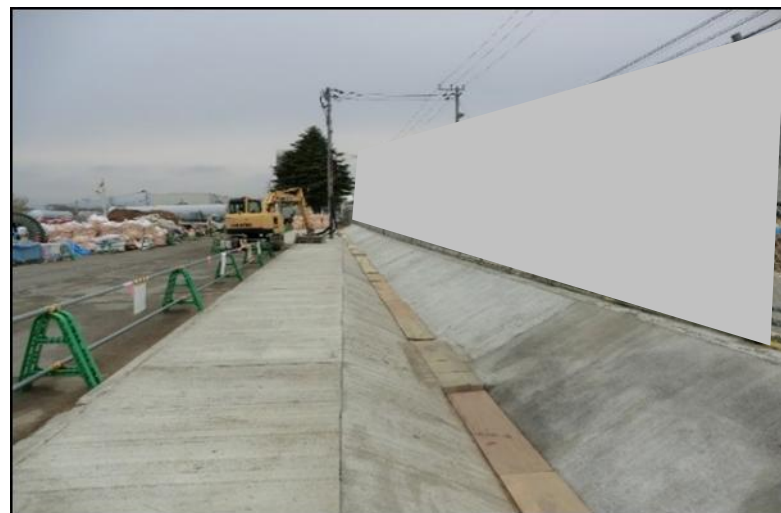
【写真⑨(35m盤)】西側エリア:舗装施工後
