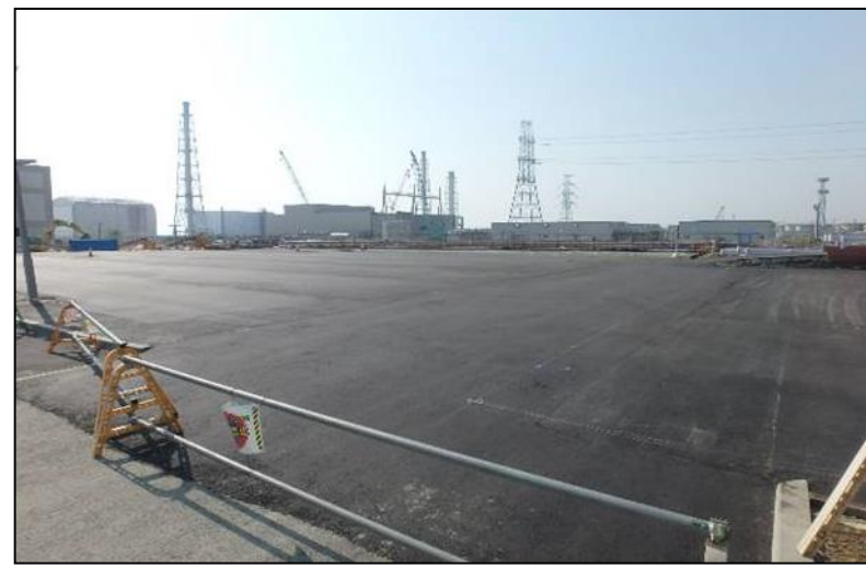
【写真②(35m盤)】北側エリア:舗装施工後
