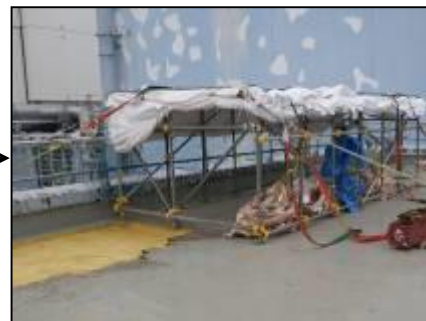
【写真⑧】仮設テント盛替状況 (4月1日)
