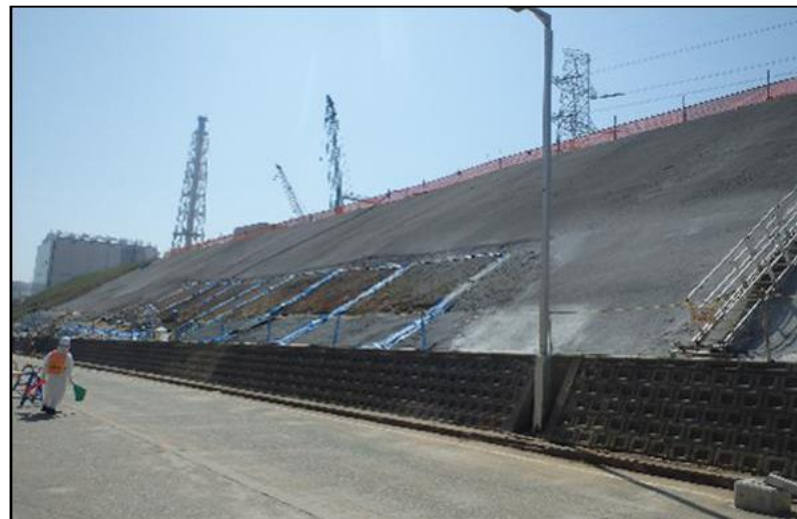
【写真③(35m盤)】1～4号法面:モルタル吹付け施工後
