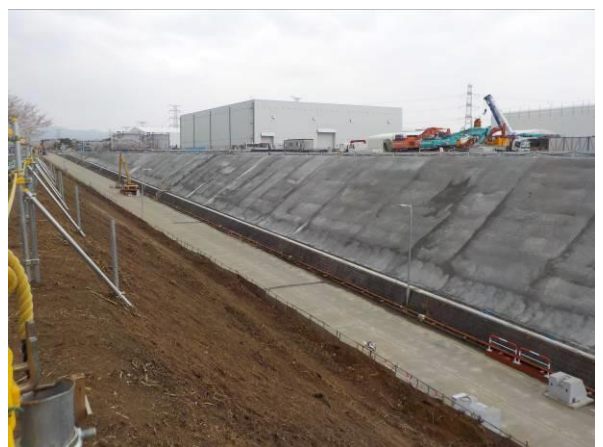
現場状況写真（写真②）
