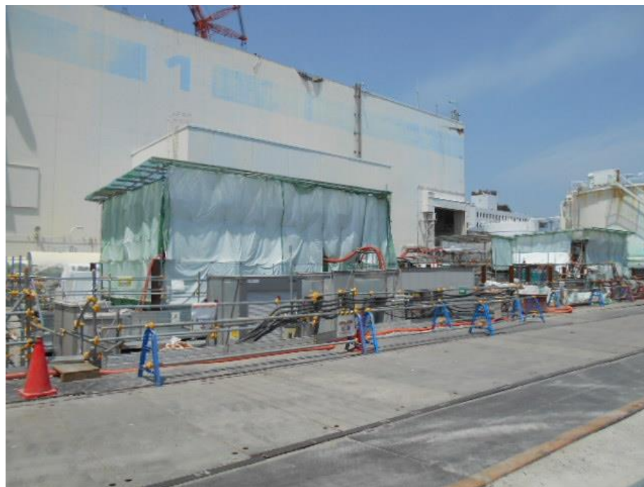
逆洗弁ピット上部の状況（作業スペースとして活用）
