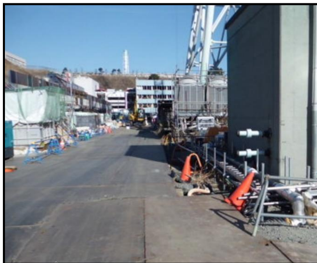
現場状況写真
