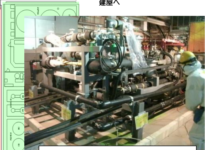
②移送配管現場設置状況
