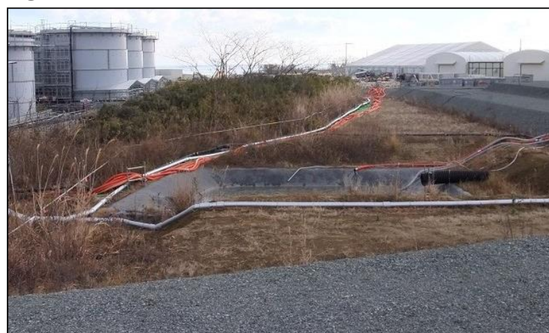
【⑩Hタンクエリア】H4タンクリプレイス干渉箇所
