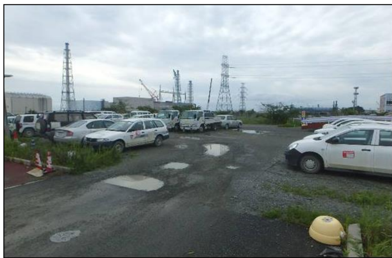
【写真②(35m盤)】北側エリア:舗装施工前
