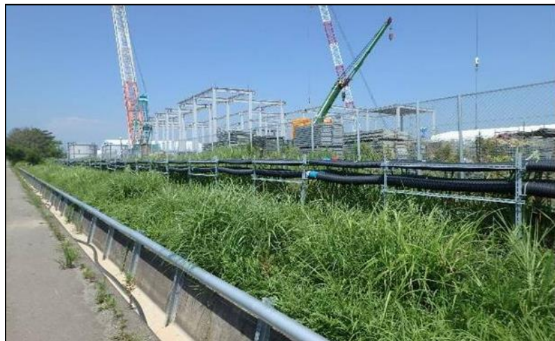
【写真①(35m盤)】北側エリア:モルタル吹付け施工前
