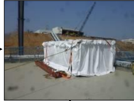
【写真④】仮設テント設置完了 (3月31日)
