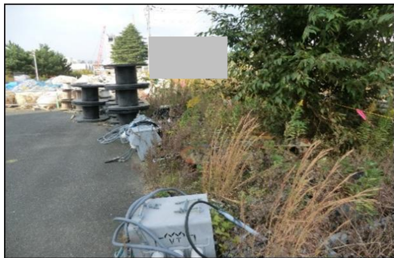
【写真⑨(35m盤)】西側エリア:舗装施工前
