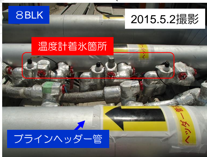
写真②：試験凍結管(№18) 着氷状況
