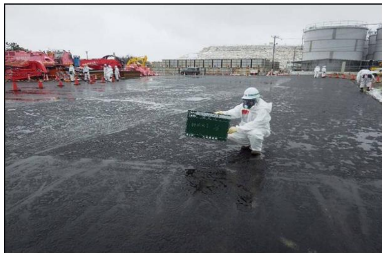
【写真⑦(35m盤)】Gタンクエリア:舗装状況
