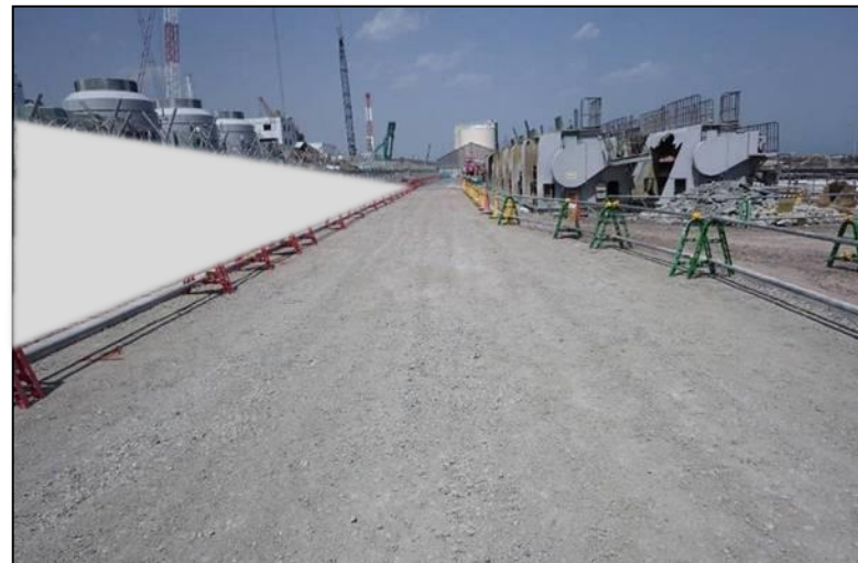
【写真⑩(4m盤)】2-3号機間:アスファルト舗装施工前
