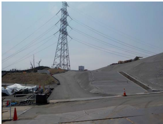
現場状況写真（写真①）
