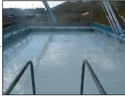
【写真③】ウレタン防水完了 (3月14日)
