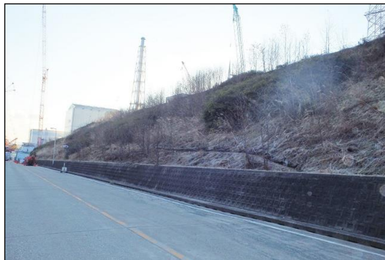
【写真③(35m盤)】1～4号法面:モルタル吹付け施工前
