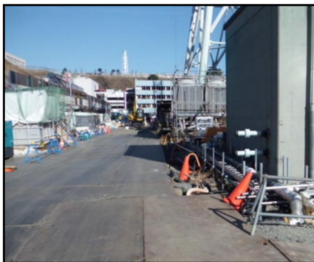
現場状況写真
