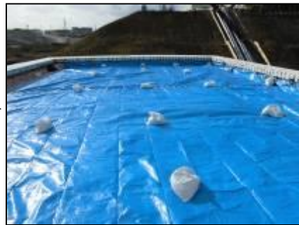
【写真②】ブルーシート設置 (3月2日)
