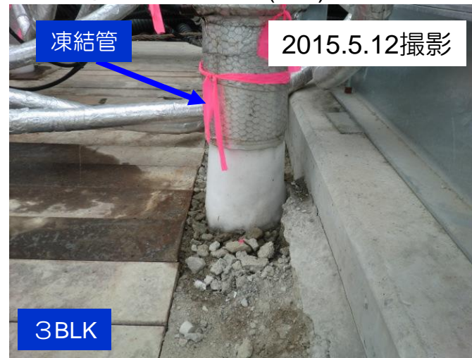
写真③：試験凍結管(№5)着氷状況
