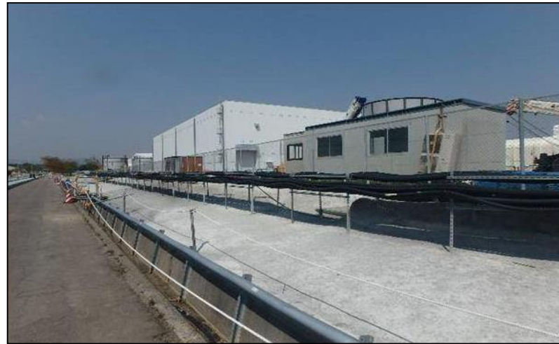
【写真①(35m盤)】北側エリア:モルタル吹付け施工後
