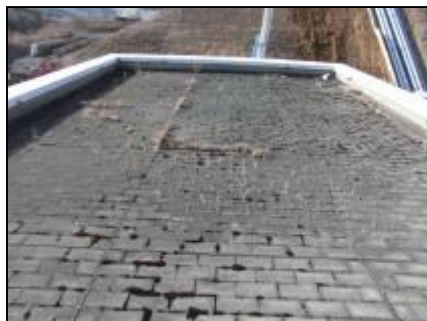
【写真①】作業前
