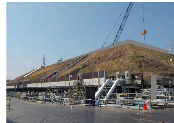
現場状況写真（写真②）
