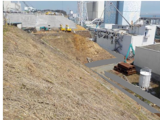
現場状況写真（写真②）
