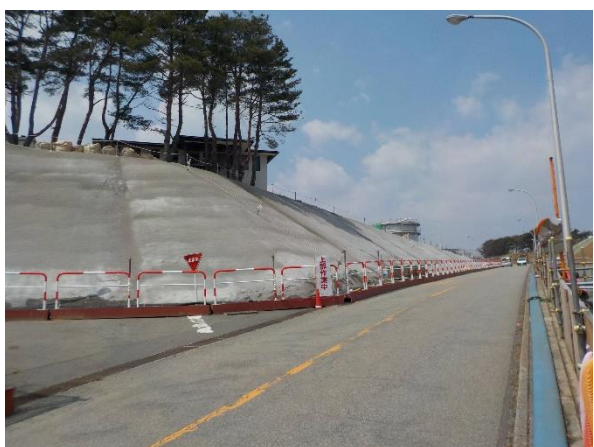
現場状況写真（写真①）
