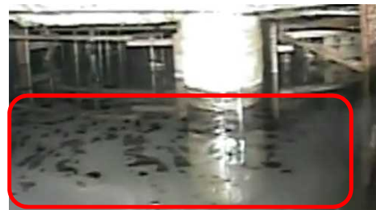
復水器エリアの滞留水表面状況
