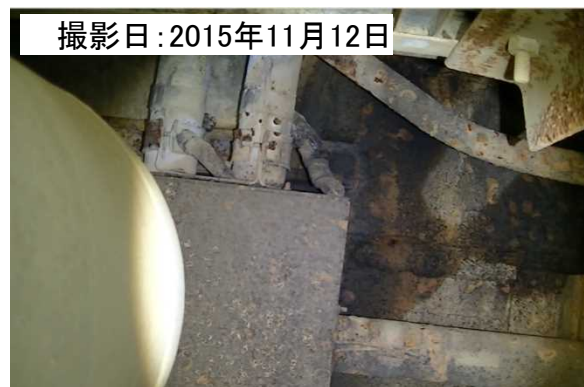
流入箇所下部の写真
