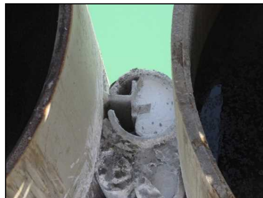
【継手部写真（モルタル充填後）】
