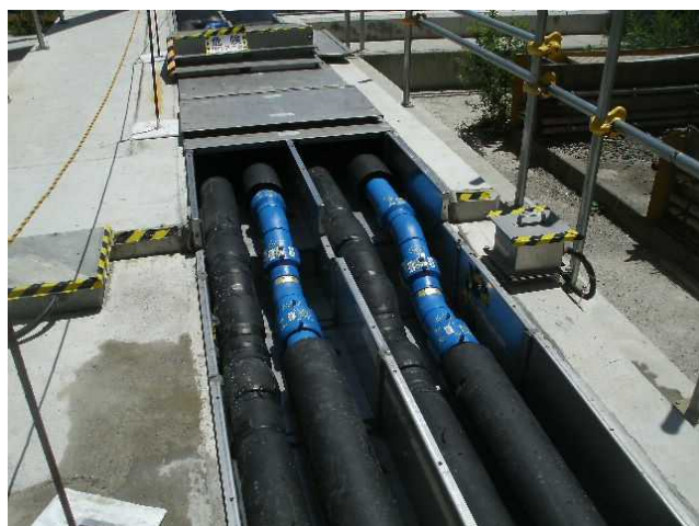
新規PE管施工状況
