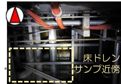
1階開口部から床ドレンサンプを見下ろした状況
