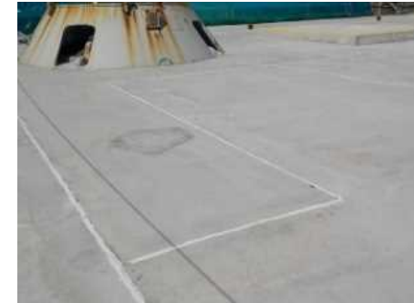
4m盤フェーシング 継手止水
