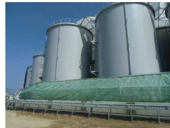
タンク堰カバー・雨樋
