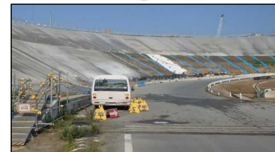
モルタル吹付け施工状況
