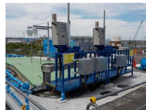
B・C排水路ゲート弁設置・電動化
