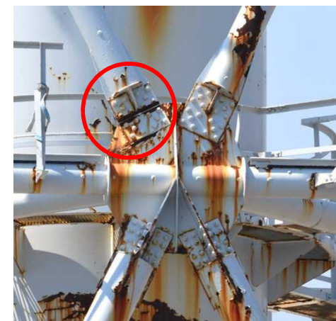
破断箇所（例）
