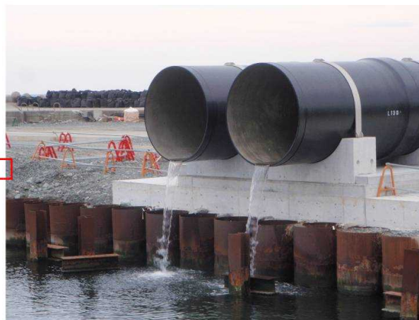
付替後排水路出口
