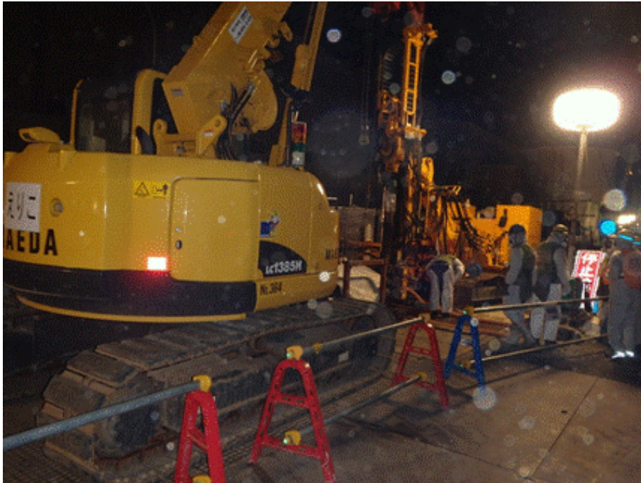
写真⑪-1 11BLK複列施工(削孔)
