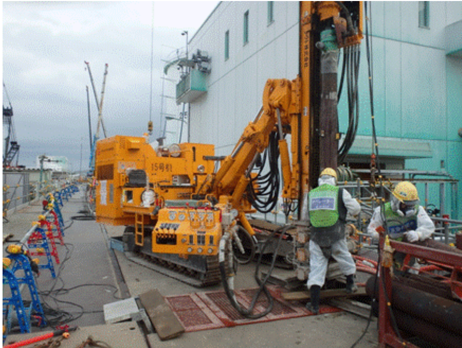
写真⑫-1 12BLK複列施工(削孔)
