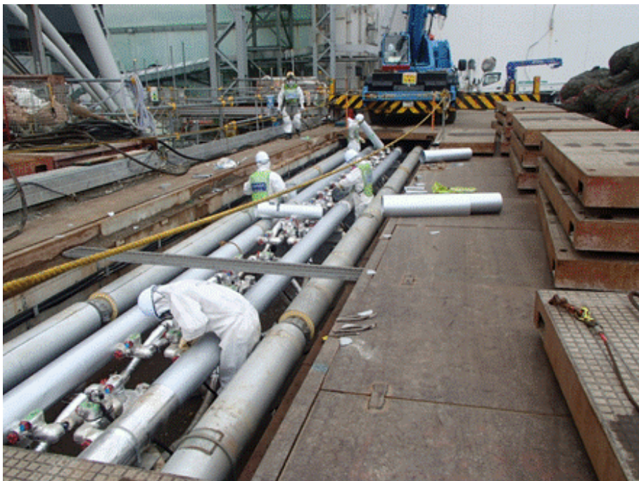
写真⑨ 9BLK配管設置
