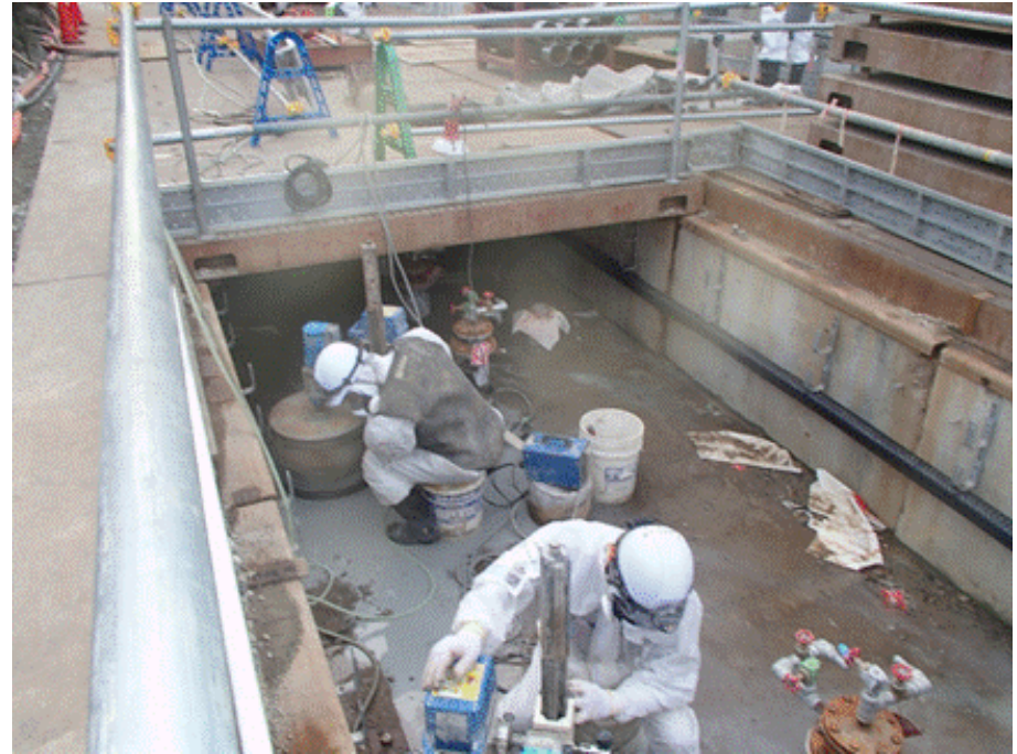
写真⑩-3 10BLK路下トレンチ施工
