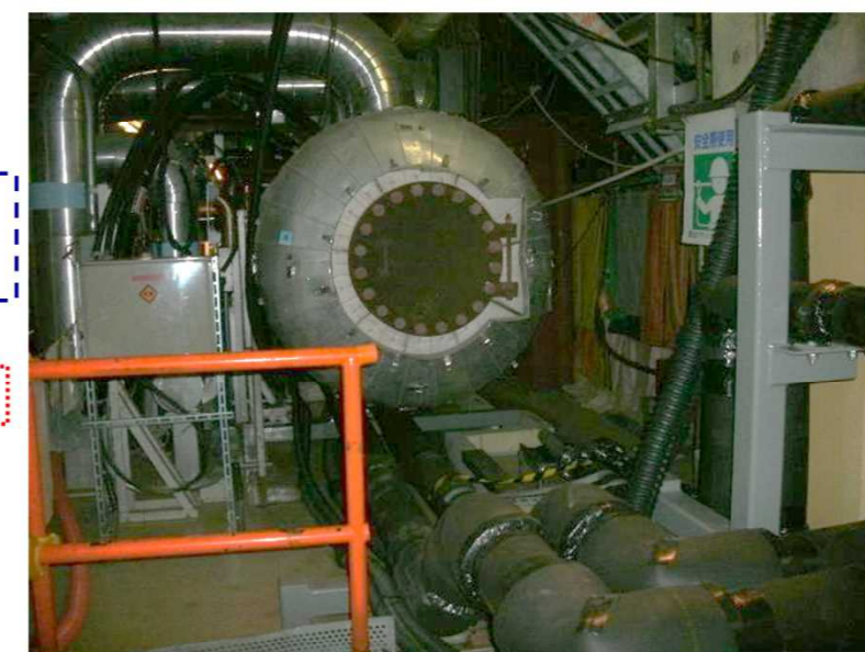
写真⑬：ヒータールーム南西から開口部（干渉物&遮蔽あり） 写真ヒーターの右奥が地下階からの開口部であるが狭隘であり人の通行は困難。開口部脇には写真⑫と同様に遮蔽あり
