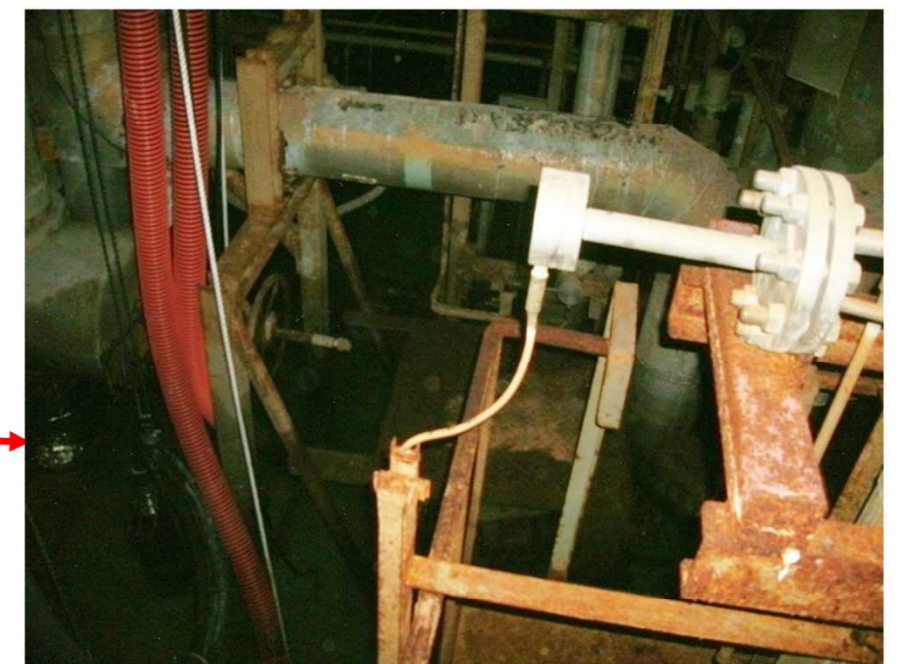
写真②-2：階段下・北側の柵からOP1900撮影 線量約20mSvh 視認性は悪いもののOP1900の床面に水面がある事が確認できる。機器が混在し狭隘なため、除染装置のアクセス・作業が困難。
