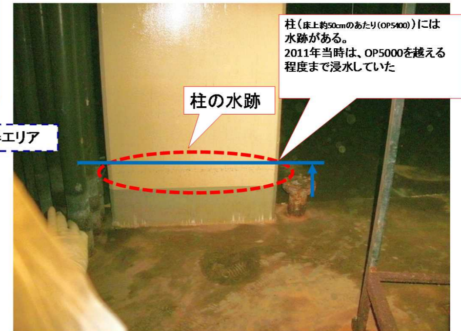
写真④：ヒータールーム地下1階、柱の水跡（東面）西向き撮影 柱には、津波後に浸水した跡が付いている。
