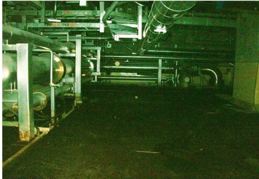
写真⑤: 階段下より西向き撮影 (左の配管は南壁沿い) 床面は湿っていた。
