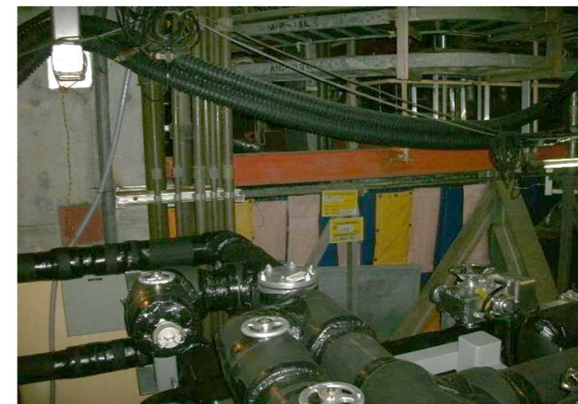
写真⑫：1階ヒータールーム南西から開口部を見た写真 開口部の手すりには遮蔽が設置されている。 開口部周辺は滞留水移送配管等が敷設され狭隘なため現状作業は困難
