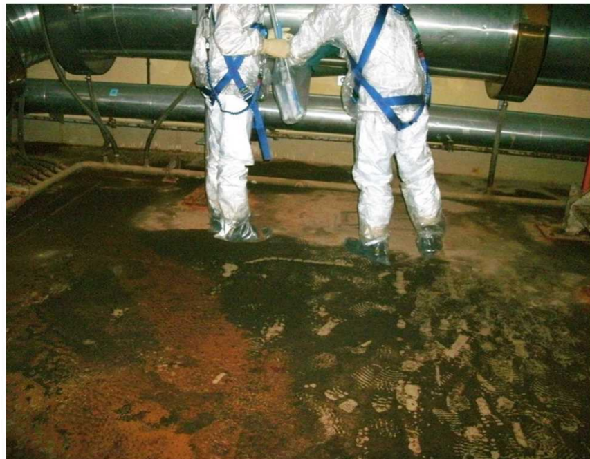
写真①：ヒータールーム地下1階、南側階段降りた前床面には水は無いが、湿った砂があり歩くと足跡が付く
