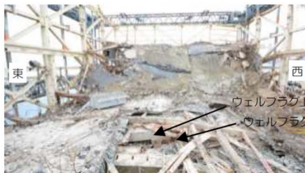
<オペフロの様子（崩落屋根等）>
