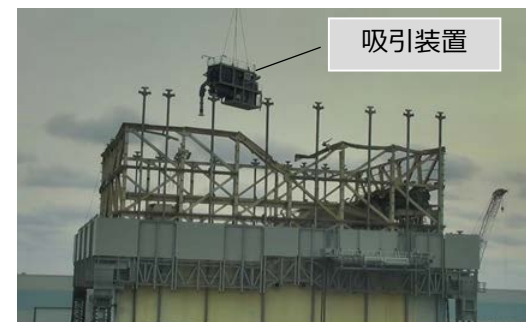
ガレキ撤去の作業状況（2018年1月22日）
