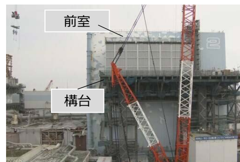
原子炉建屋西側の構台と前室
