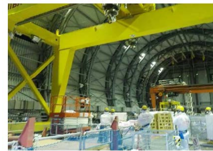
クレーンと燃料取扱機
