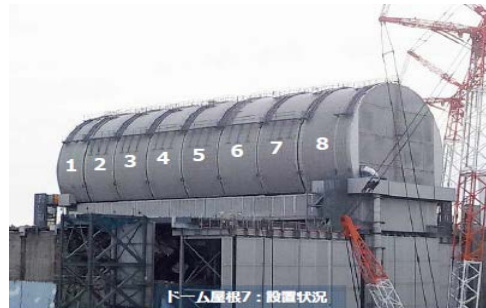
ドーム屋根の設置完了（2018年2月23日）
