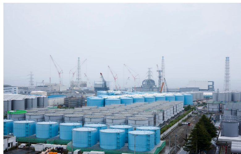
大型休憩所からのタンクエリア俯瞰
