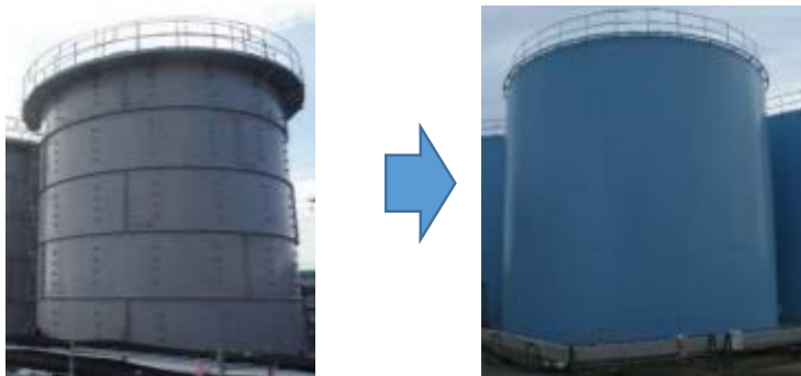
【溶接型タンクへの切替え】
