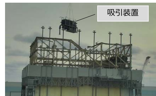
ガレキ撤去の作業状況（2018年1月22日）
