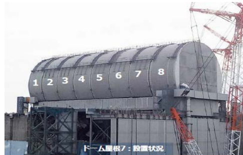
ドーム屋根の設置完了（2018年2月23日）
