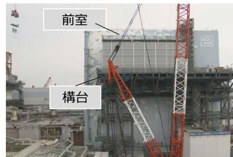
原子炉建屋西側の構台と前室
