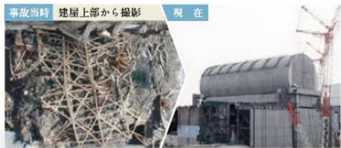
＜参考＞ 3号機の状況(左：事故当時、右：現在)
