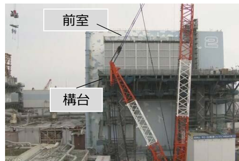
原子炉建屋西側の構台と前室
