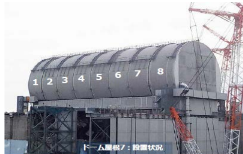
ドーム屋根の設置完了（2018年2月23日）
