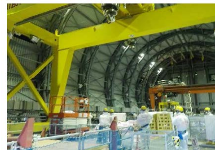
クレーンと燃料取扱機
