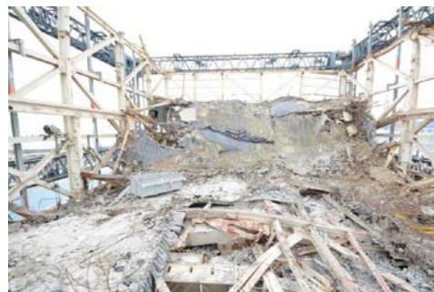
建屋上部のガレキの状況
