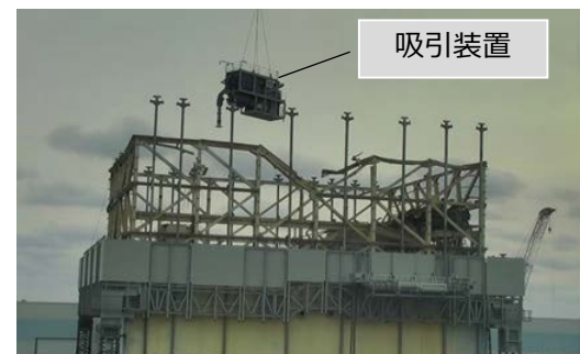
ガレキ撤去の作業状況（2018年1月22日）
