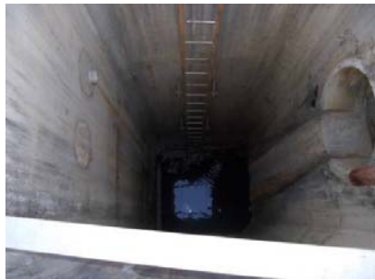
①' 2号機上流側立坑
