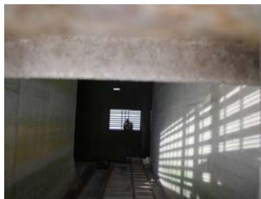
② 1号機下流側立坑
