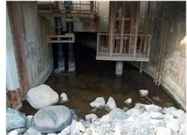
③ 1号機放水口
