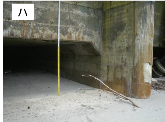
4号機内は堆砂により閉塞
