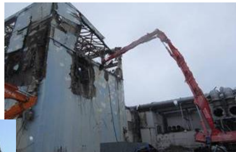
4号機瓦礫撤去作業
