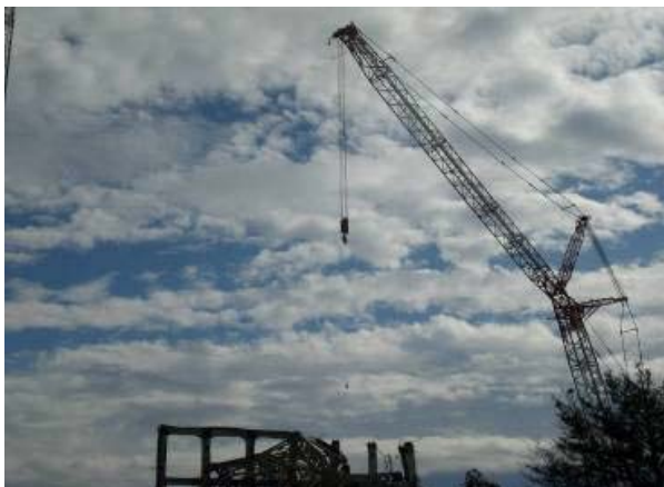
原子炉建屋上部の測定の様子
