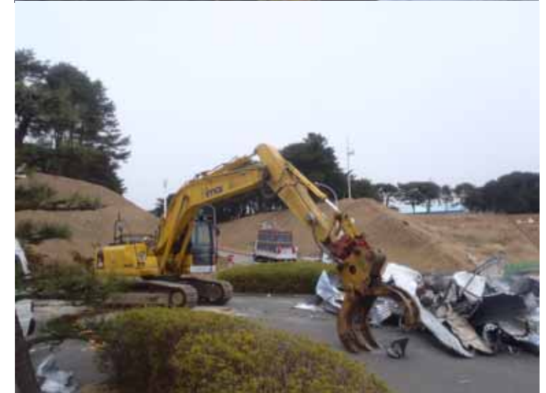
地面でのガレキ撤去
