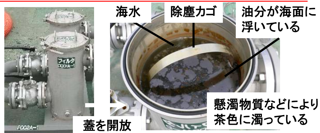
図3. 装置入口のフィルタ部 とフィルタ内部の状況
